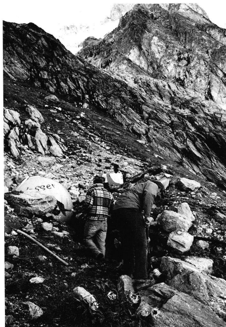
Diese Seite: Unterhaltsarbeiten an Weg und Infrastruktur der Schreckhornhütte Photos: H.-P. Styrner
