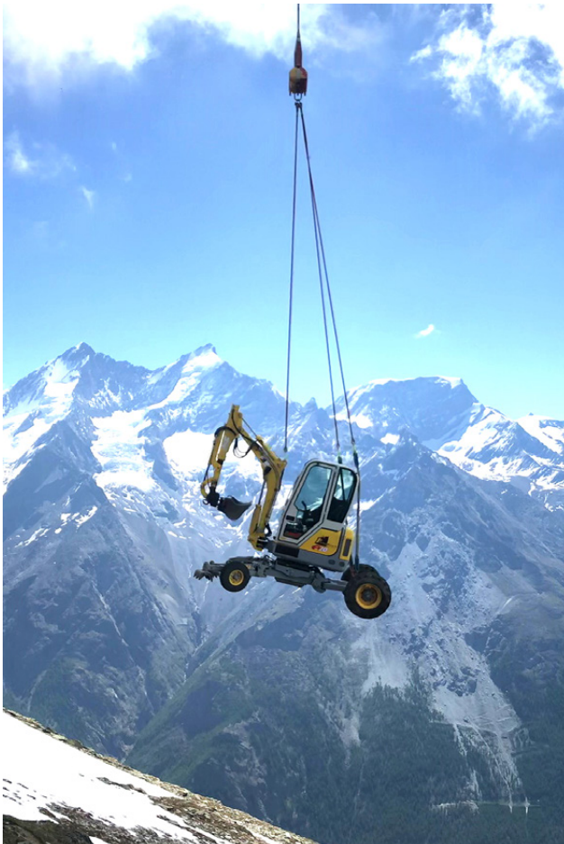
Das «Baggerli» wurde mit dem stärksten Helikopter der Schweiz, der Kamov KA 32, von der Firma Heliswiss hochgefliegen (bis 5 t Traglast!).
