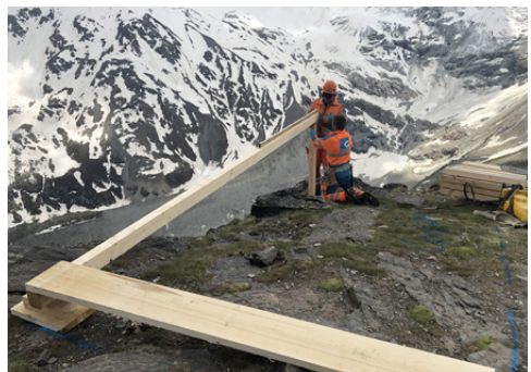
Installation für den Werkzeug-Container auf der Hüttenterasse
