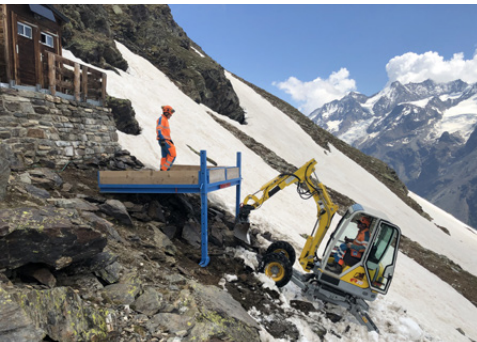
Installation für den Sanitär-Container
