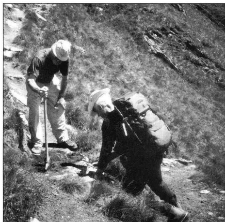
Im Sommer 1995 wurde der Weg zur Schreckhornhütte saniert.
