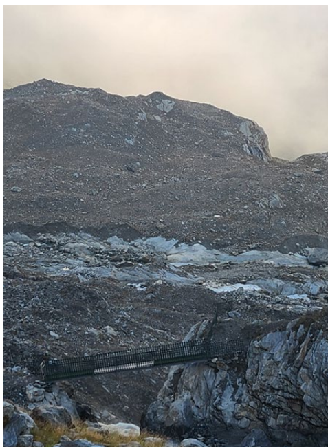
Brücke über die weisse Lütschine (Position 7)
