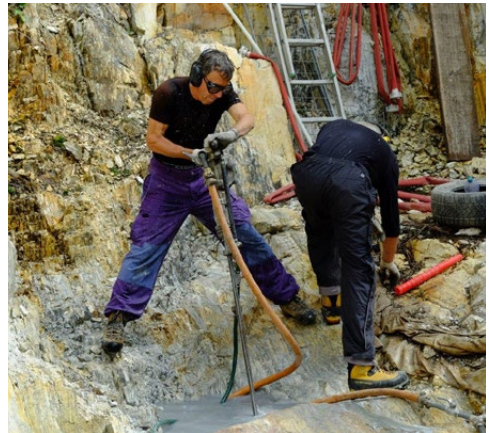
Caspar am Bohren von Sprenglöchern am Lenggenbach. Fotos: zVg.
